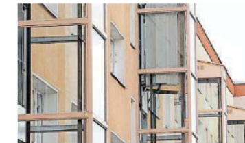
Angebaut: Im Großenhainer Kollwitzviertel sind Aufzüge nachträglich außen angebracht worden. Doch ein Renner bei Genossenschaften liegt derzeit im Innern.
