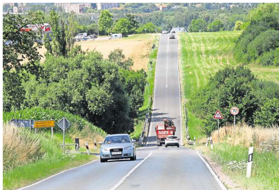
Bevor der eigentliche Straßenbau an der Gake beginnt, müssen Bäume und Sträucher weg. Am Montag sollen diese Vorarbeiten beginnen. Foto: Gerhard Dörner
