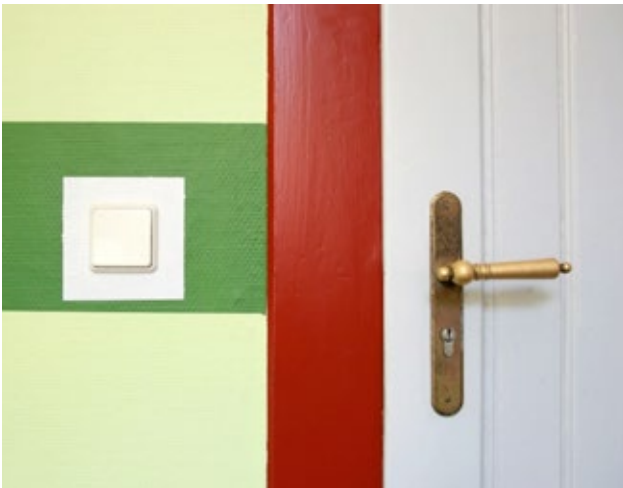
Farbige und kontrastreiche Gestaltung von Wand und Tür (© SFZ)
